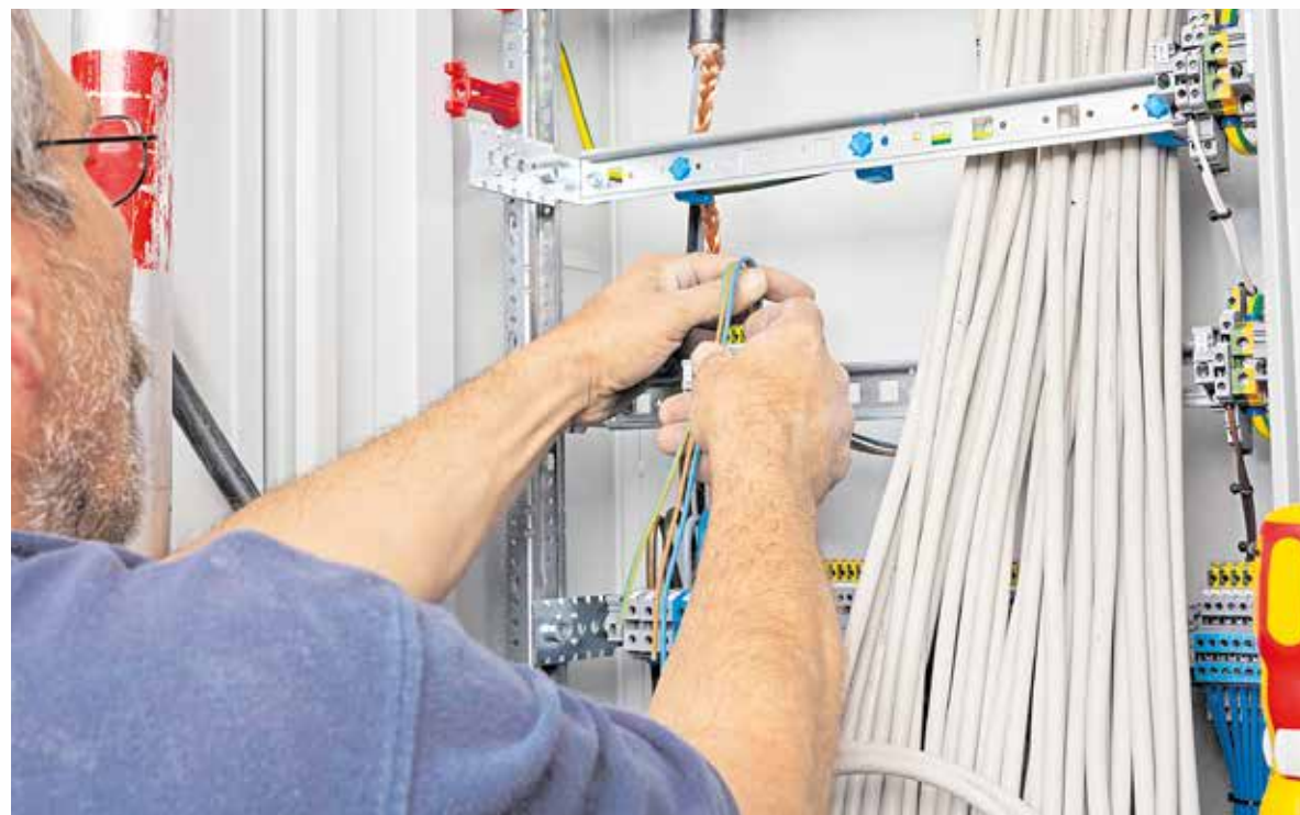
Nach der Erneuerung der Elektroinstallation eines Verbrauchers verweigerte dieser die Zahlung, weil er vom Unternehmen nicht korrekt über sein Widerrufsrecht aufgeklärt worden war. Der Fall ging bis zum Europäischen Gerichtshof. Der Verbraucher bekam Recht und das klagende Unternehmen erhält kein Geld für seine erbrachte Leistung.
