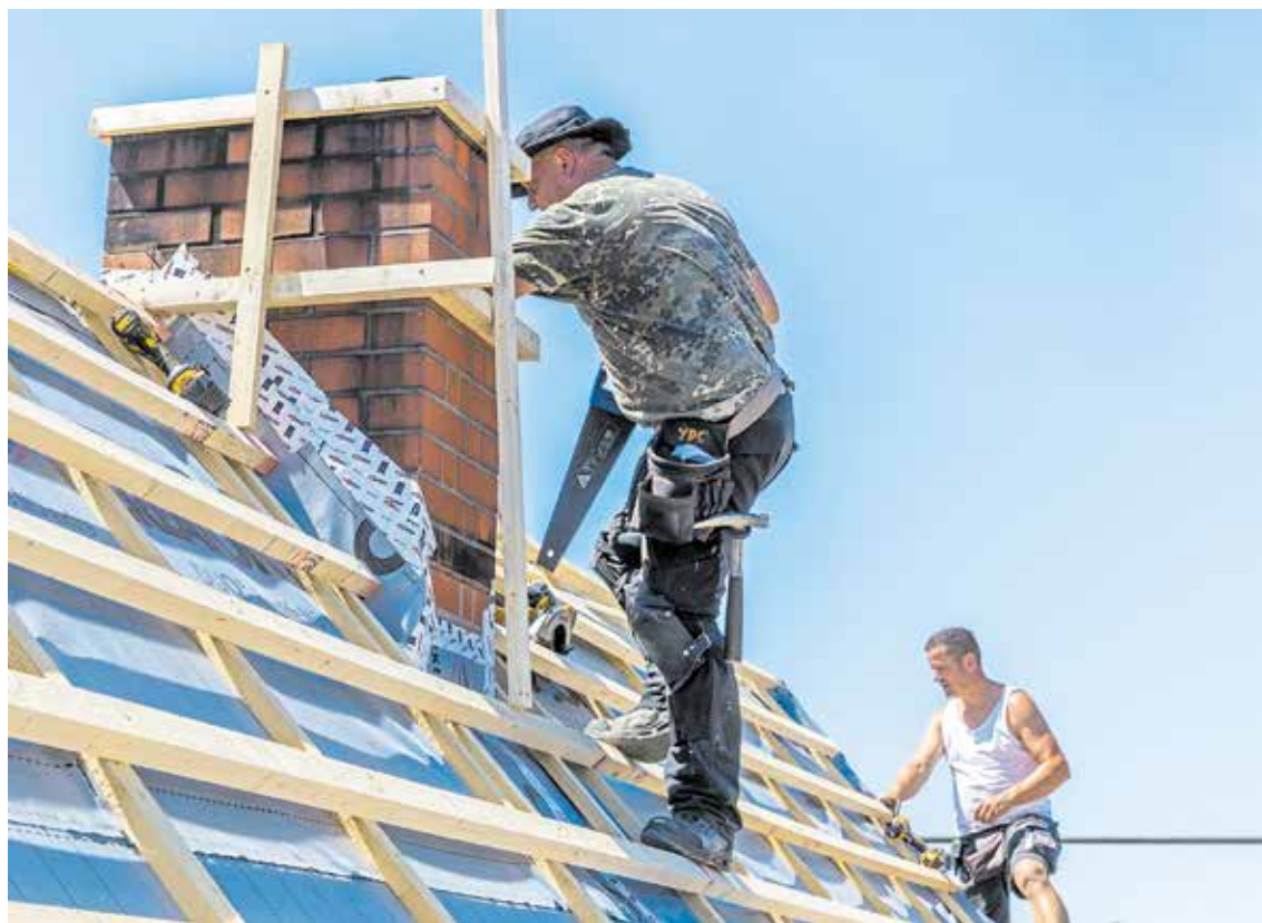
Dachdecker in Brandenburg: Sie müssen auch bei großer Hitze draußen arbeiten. Foto: picture alliance/dpa/Hammerschmidt
