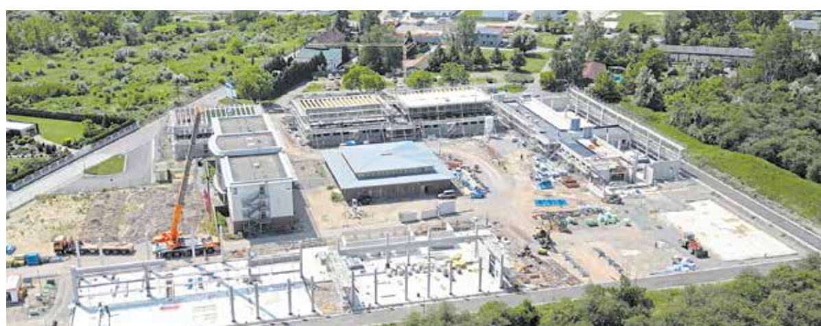
Es tut sich viel auf dem Campus-Gelände in Halle-Osendorf. Wo jetzt noch gebaut wird, soll später nach neuesten Standards aus- und weitergebildet werden.
