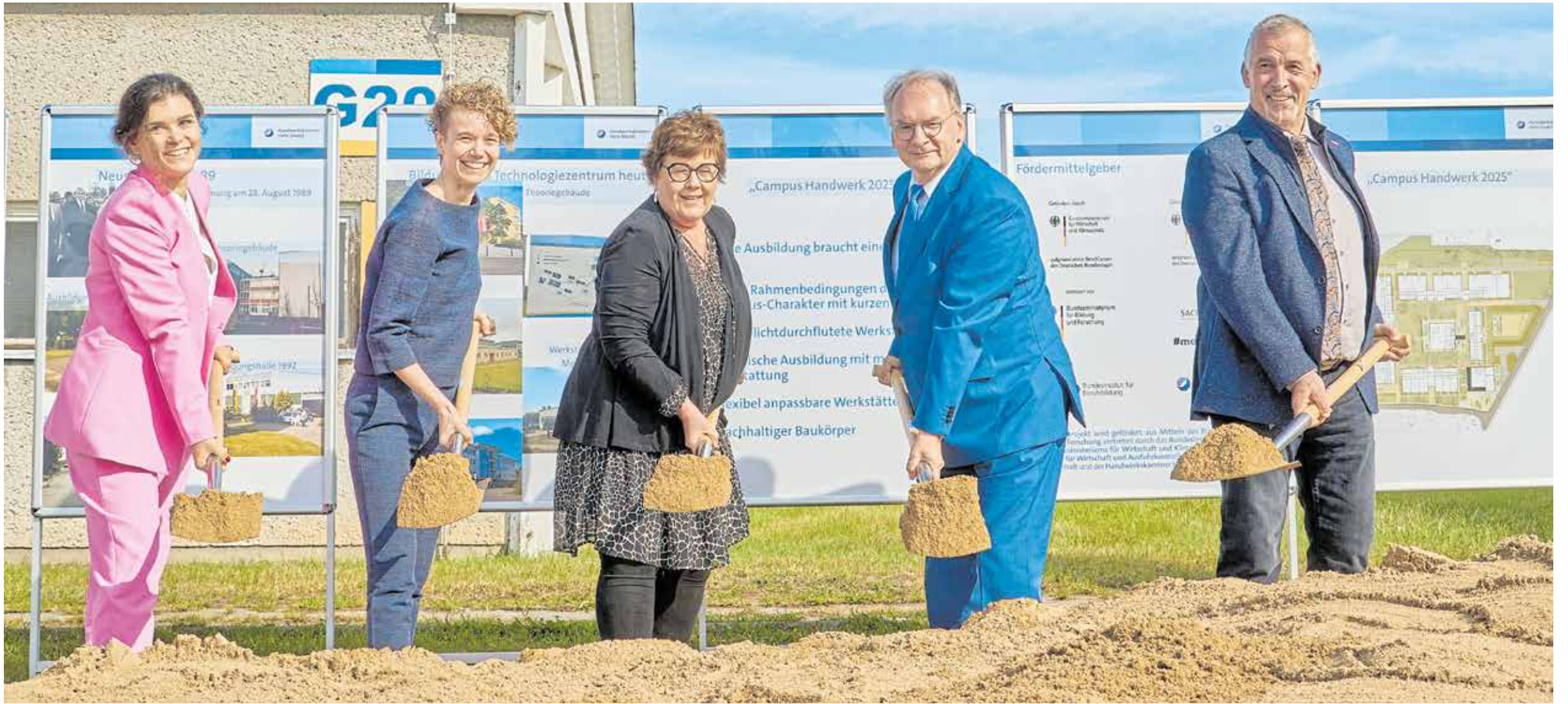
Vollzogen den symbolischen ersten Spatenstich für den Campus Handwerk (v.l.): Architektin Sarah Wiencke, Dr. Johanna Börsch-Supan, Abteilungsleiterin Allgemeine und berufliche Bildung im Bundesministerium für Bildung und Forschung (BMBF), Petra Grimm-Benne, Ministerin für Arbeit, Soziales, Gesundheit und Gleichstellung des Landes Sachsen-Anhalt, Dr. Reiner Haseloff, Ministerpräsident des Landes Sachsen-Anhalt, und Thomas Keindorf, Präsident der Handwerkskammer Halle. Foto: HWK Halle/Yvonne Bachmann
