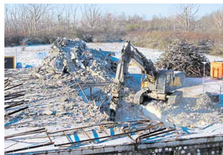
Beim offiziellen ersten Spatenstich für den neuen Campus Handwerk stand sie noch - nun ist die frühere Ausbildungshalle Geschichte.
