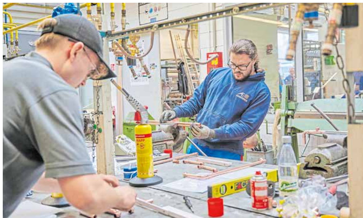
Antony Deventer (l.) und Aaron Elzemann beim Bau der Kupferburg. Mit rund zwei Stunden Zeit mussten die Handwerker schnell und konzentriert arbeiten. Foto: HWK Halle/Yvonne Bachmann
