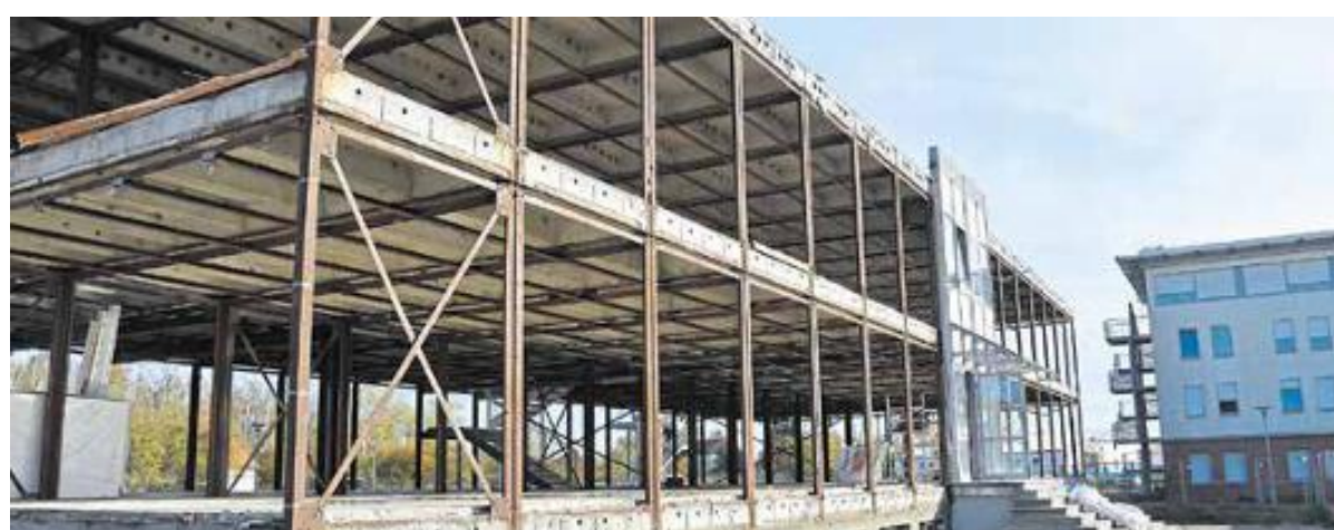
Altes muss Neuem weichen. In Halle-Osendorf entsteht bis 2025 ein neuer Campus für die Ausbildung im Handwerk. Gebaut werden ein Schulungsgebäude sowie Werkstatthalen.
