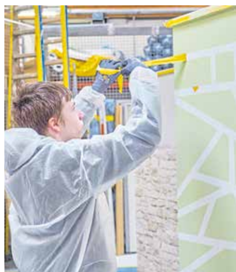
Nach dem Streichen hieß es, die Abklebung wieder entfernen.
