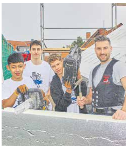
Bei einer Altbausanierung halfen die Schüler bei der Dämmplattenverlegung.
