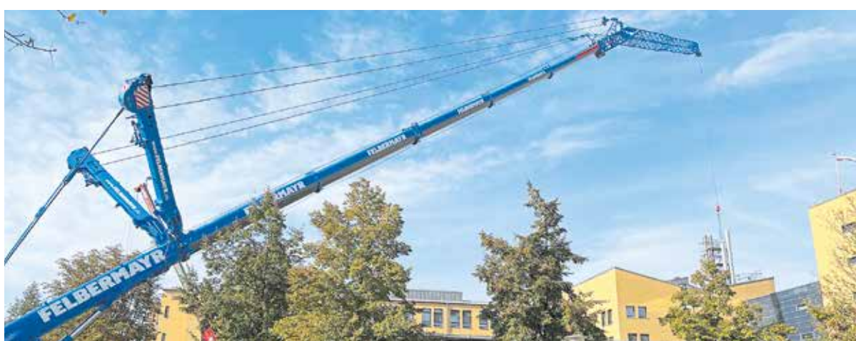
Das Klinikum Bergmannstrost in Halle erhält neue Schornsteine. Beim ersten Austauschtermin kamen ein Hilfskran sowie ein 250-Tonnen-Schwerlastkran mit einer Mastlänge von knapp 100 Metern zum Einsatz. Foto: Günter Schulz GmbH & Co. KG
