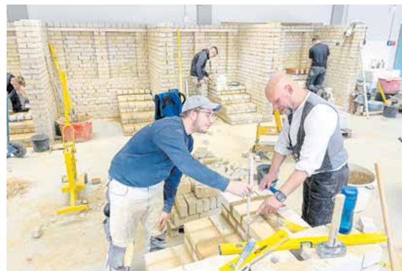
Cedric Richter, Auszubildender zum Hochbaufacharbeiter im 2. Lehrjahr, bekommt von Ausbilder Thomas Hahnemann Tipps zu seiner gemauerten Treppe während der überbetrieblichen Lehrausbildung am Standort Holleben. Foto: HWK Halle/Tobias Kirchner
