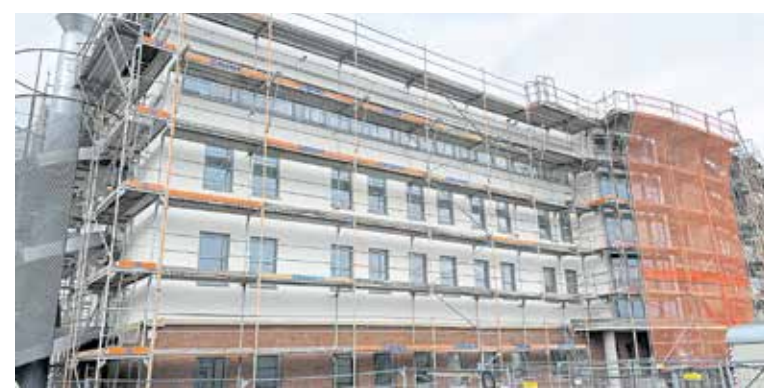
Nicht nur die Fassade des Gästehauses wird neu gestaltet, auch innen findet eine komplette Modernisierung statt. Foto: HWK Halle/Tobias Kirchner
