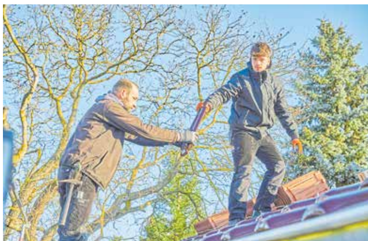
Lehrling Alexander Schäfer (r.) deckt mit seinem Kollegen das Dach eines Carports.
