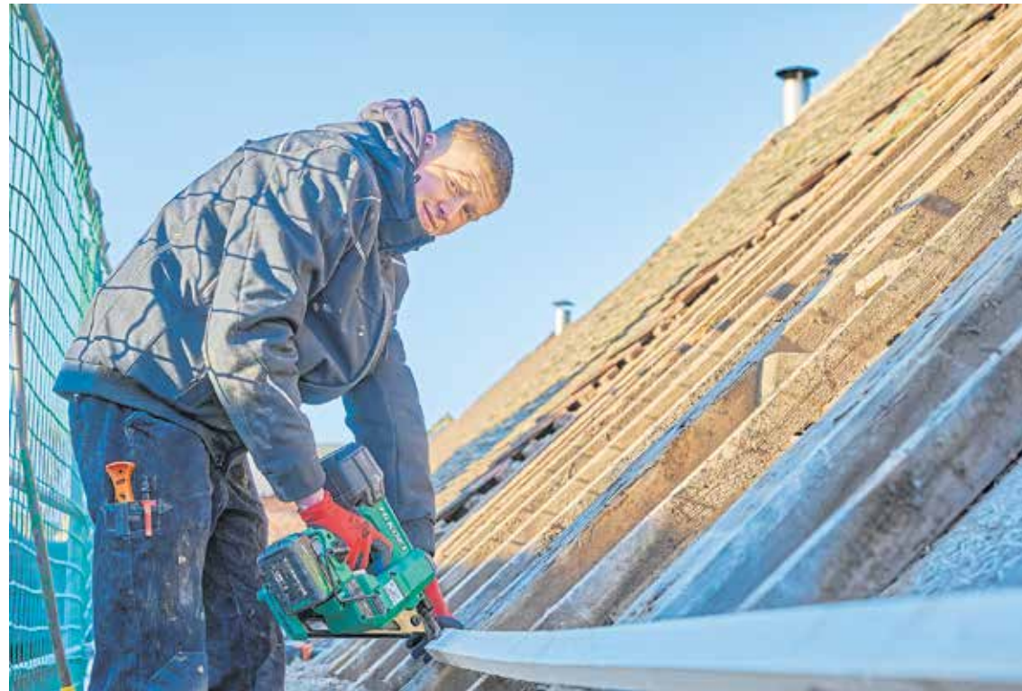
Nick Tukay auf der Baustelle. Bei winterlichen Temperaturen saniert der Auszubildende mit seinen Kollegen das Dach einer alten Scheune. Foto: HWK Halle/Yvonne Bachmann
