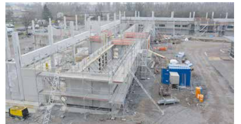
Auf der Südseite des künftigen Campus stehen bereits die Betonwände für das Theoriegebäude sowie die Elektro- und SHK-Werkstätten.
