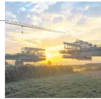
Foto: Hentschke Bau
