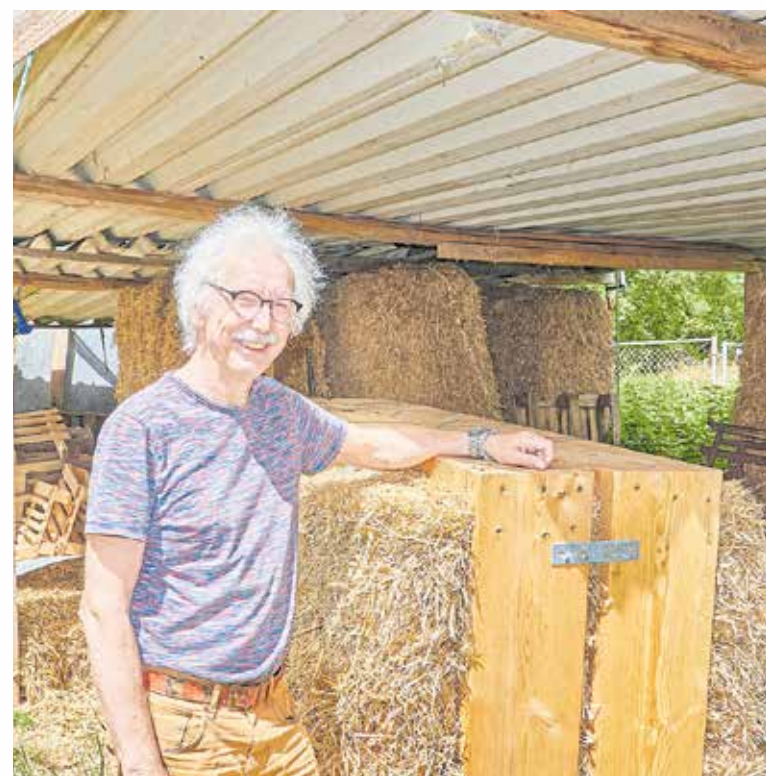
Die Strohelemente wiegen je zwischen 150 und 200 Kilogramm, sind 2,50 bis 3,20 Meter hoch und 1,25 Meter breit.
