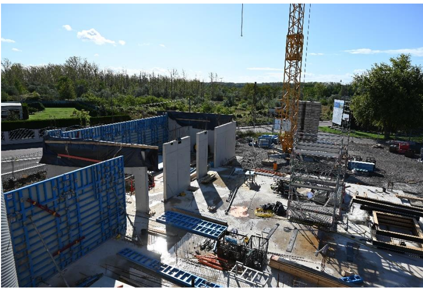
Baufortschritt am neuen Bildungszentrum
