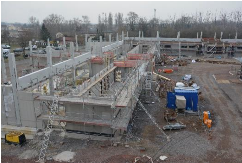
Baufortschritt am neuen Bildungszentrum
