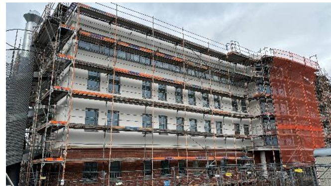
Sanierung des Gästehauses
