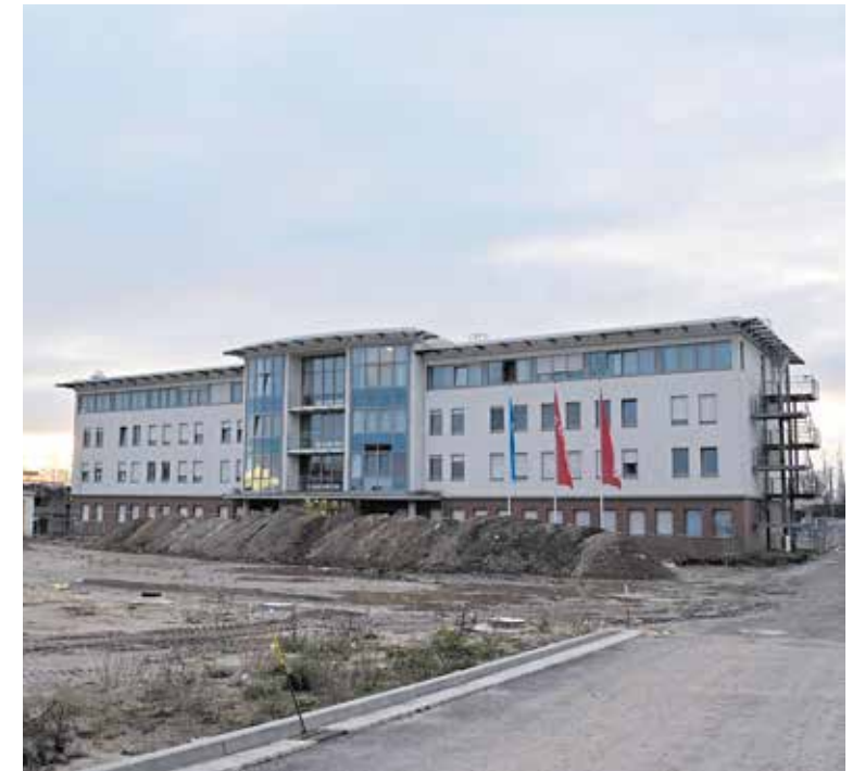
Das Gästehaus am Standort Halle-Osendorf wird von Juli bis voraussichtlich Dezember 2025 aufgrund einer umfassenden Strangsanierung geschlossen. Foto: HWK Halle
